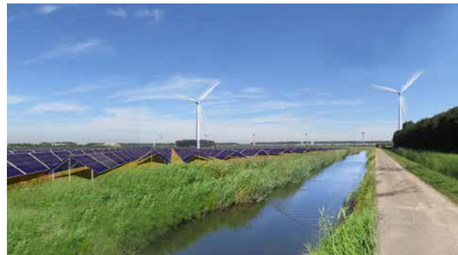
Indien open randen gewenst zijn: pas watergangen toe ter afscheiding i.p.v. hekwerken
