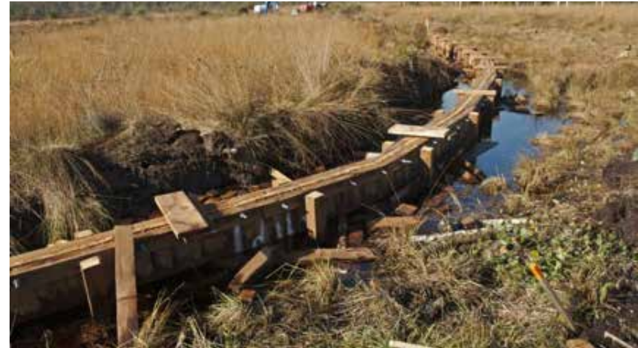
Plaatsen van damwanden voor de stimulering van veengroei, Wooldse Veen
